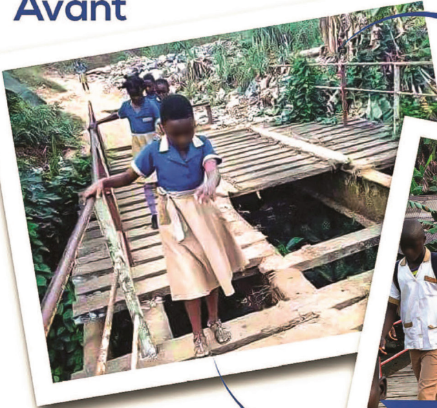
Pont Bilalang restauré, à Edéa
